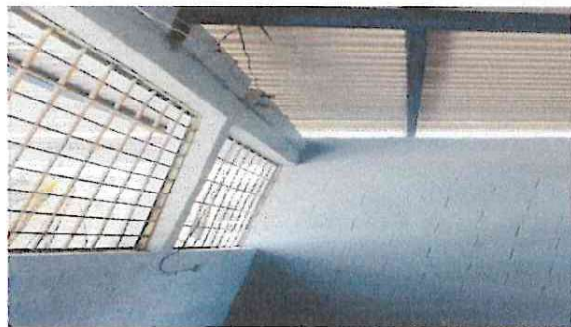
Foto 3: SISTEMA ELECTRICO DE LA ESCUELA
