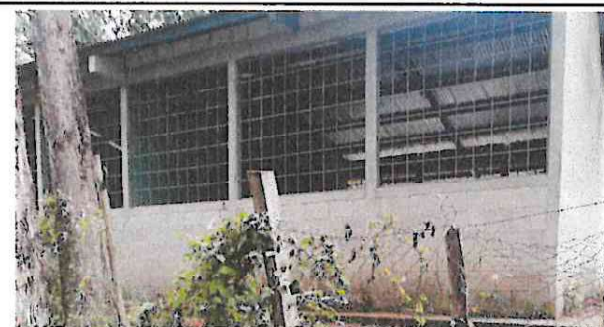
Foto 5: COLOCACIÓN DE VENTANAS EN LAS AULAS
