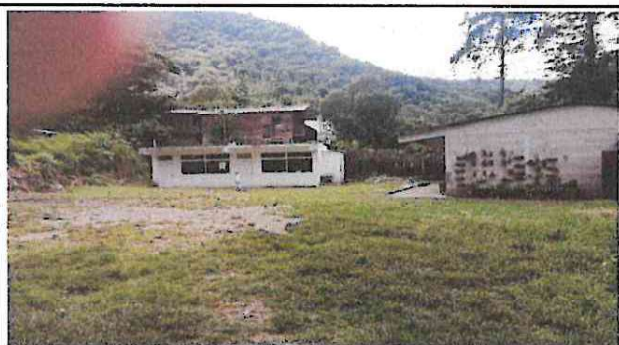
Foto 3: SUSTITUCION DE TUBERIA PARA AGUAS NEGRAS DE BAÑOS
