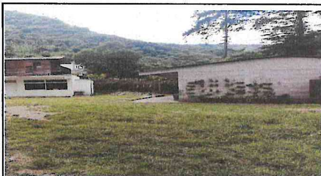
Foto 4: SUSTITUCION DE TUBERIA PARA AGUAS NEGRAS DE BAÑOS
