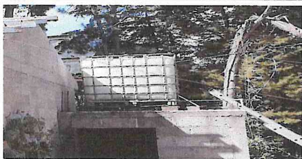
Foto 5: DEPOSITO DE AGUA
