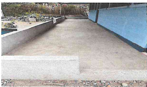
Foto 1: REPARACIÓN DEL MURO PERIMETRAL
